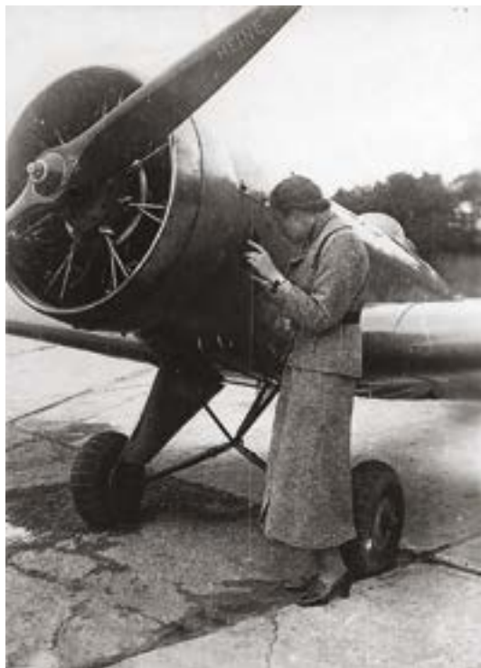
Koneessa oli 81 hevosvoiman Siemens-tähtimoottori. Yhdellä tankkauksella pystyi lentämään 1 000 kilometriä. Prinsessa tutkii, ettei öljyvuotoja ole. (Kuva: Erkki Heino)
