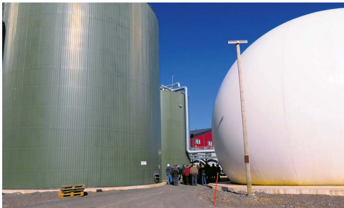
Huittisten Vampulassa toimivalla Biokaasutehtaalla on massiivia säiliöitä. Valkoinen ”pallo” on biokaasuvarasto, josta johtaa Nordkalkille 1,5 km:n mittainen kaasuputki. Kuva: Kari Nummila.
