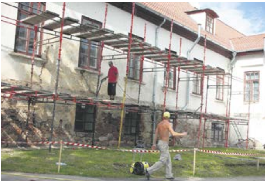
Kartanon katto on uusittu ja seinien remontti meneillään. Kiire on. Latvialainen rakennusmies jopa juoksee.
